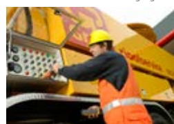
riool en vetputten
